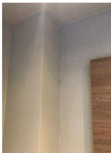
**FOTO 60: SUÍTE 321 – TRINCA NA PAREDE**
