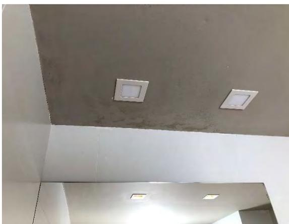
FOTO 42: SUÍTE 135 - INFILTRAÇÃO NO FORRO DO WC
