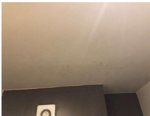
FOTO 36: SUÍTE 121 - INFILTRAÇÃO NO FORRO DO WC
