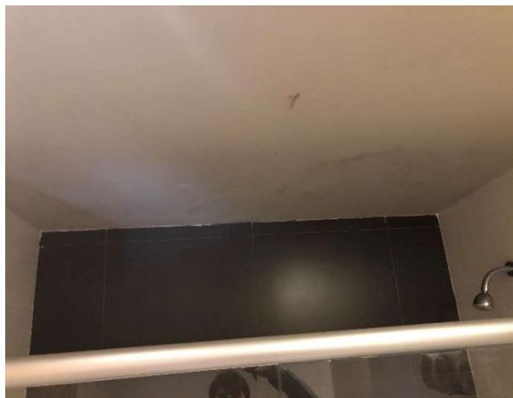
**FOTO 74: SUÍTE 402 - INFILTRAÇÃO NO FORRO DO WC**
