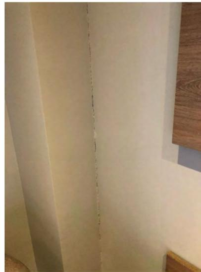
**FOTO 46: SUÍTE 221 – TRINCA NA PAREDE**
