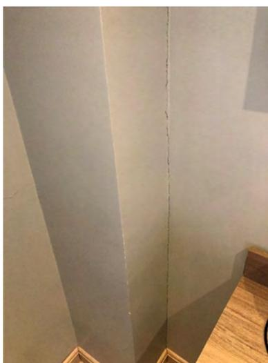
**FOTO 59: SUÍTE 321 – TRINCA NA PAREDE**
