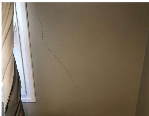
**FOTO 58: SUÍTE 321 - TRINCA NA PAREDE**
